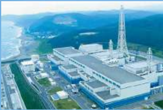
柏崎刈羽原子力発電所の外観(5~7号機)
